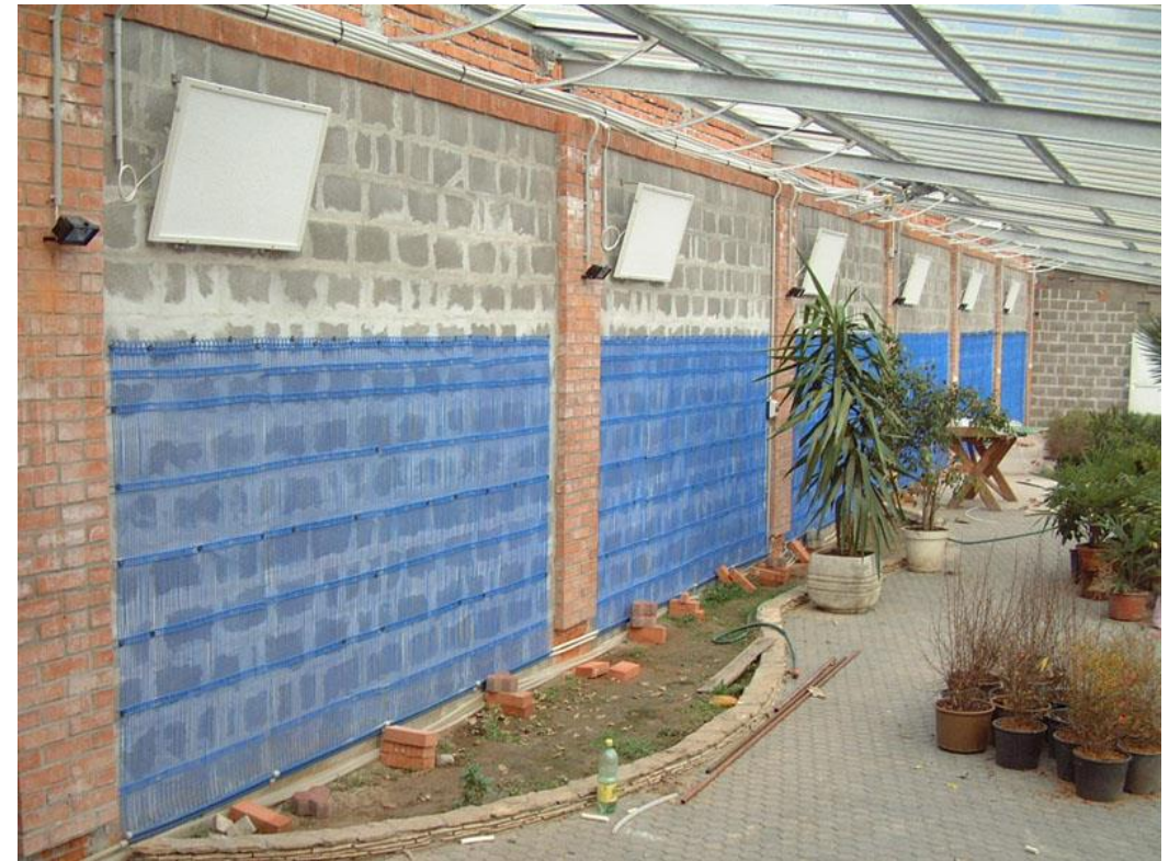
Монтаж капиллярных матов на стены открытым способом
