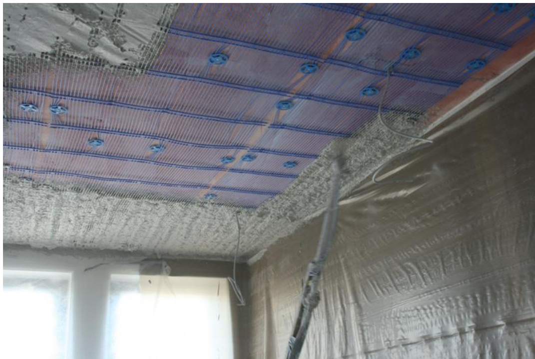
Нанесение первого слоя штукатурки
