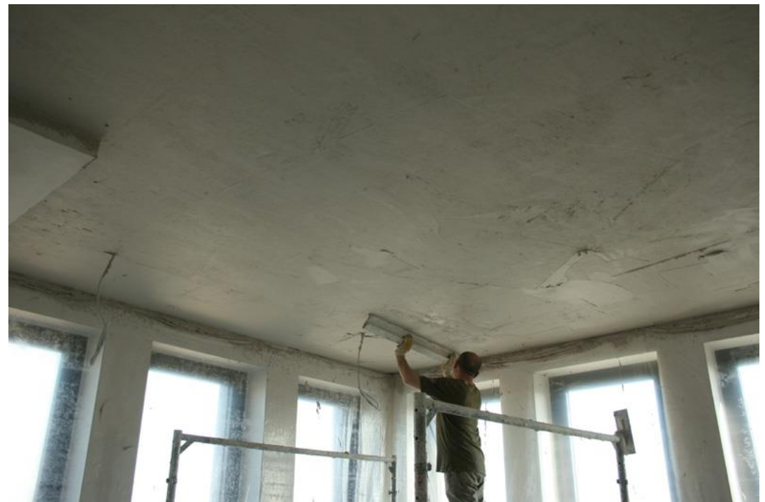
Выравнивание второго слоя штукатурки
