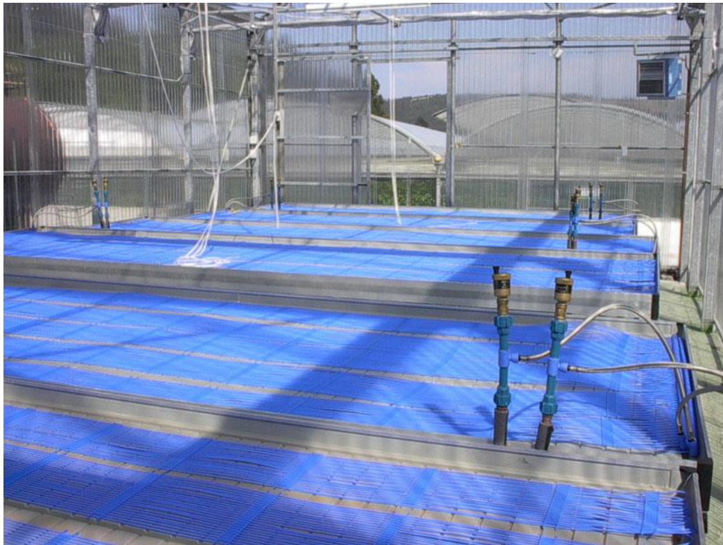
Укладка капиллярных матов на пол
