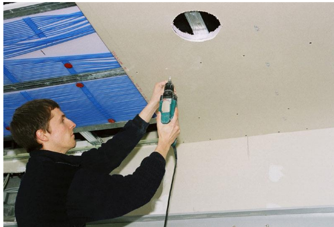
Укрепление панелей гипсокартона
