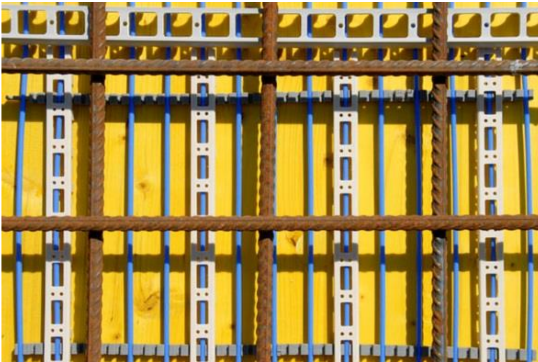
Укладка стальной арматуры
